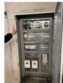
Variadors de freqüència d'una UTA de piscina
